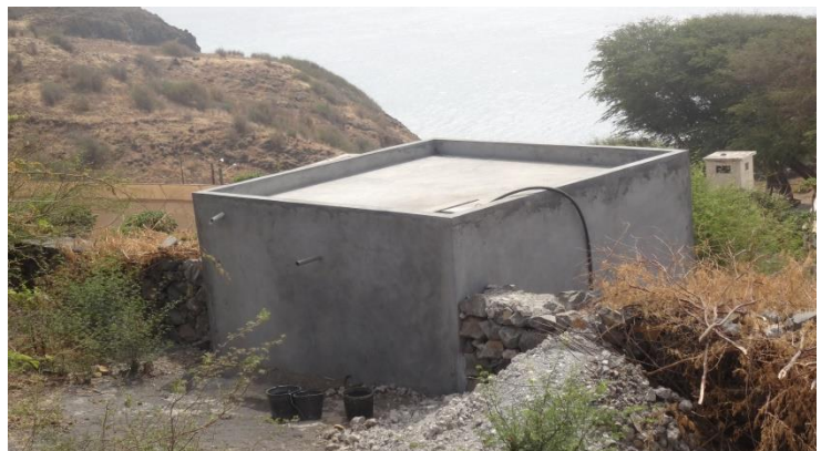
De in 2016 gerenoveerde cisterne
