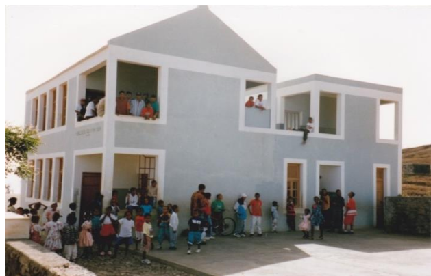
Eén van de door WvL gebouwde scholen
