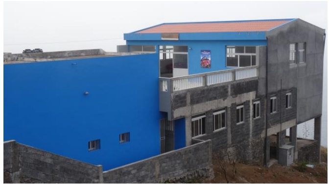
Op de bepleistering na afronding fase 2 Gemeenschapshuis
