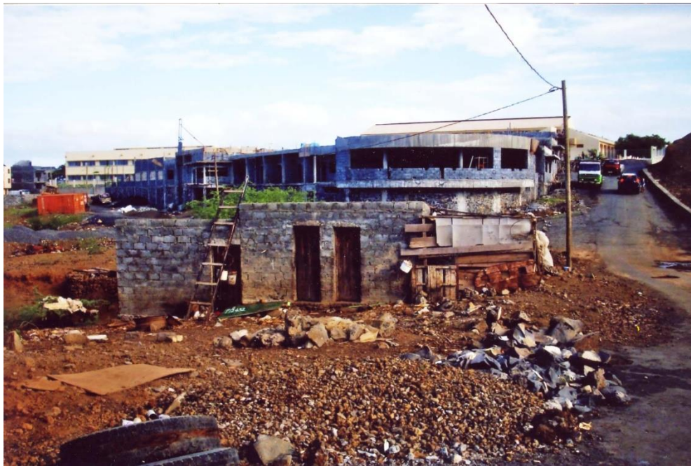
De technische school in San Filipe in aanbouw
