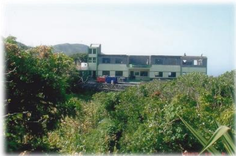
Vorderingen van de bouw van de technische school in 2007
