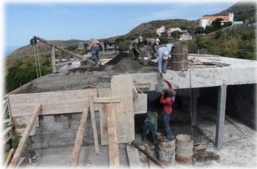
Bouwvakkers bezig met de tweede verdieping
