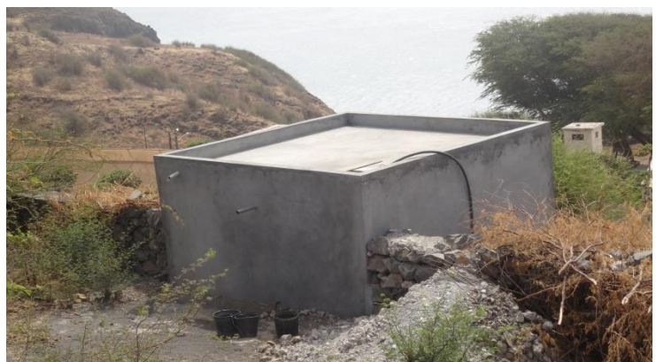
De in 2016 gerenoveerde cisterne
