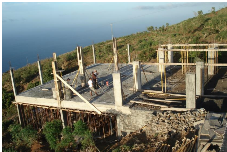
Het gemeenschapshuis in aanbouw
